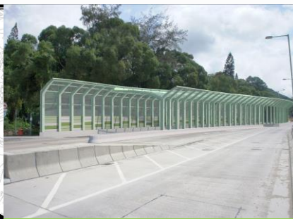
清水灣道與安秀道路口 道路改善工程
