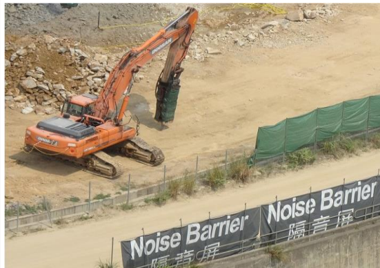
使用比傳統施工設備更安靜的優質機動設備（QPME）機械
