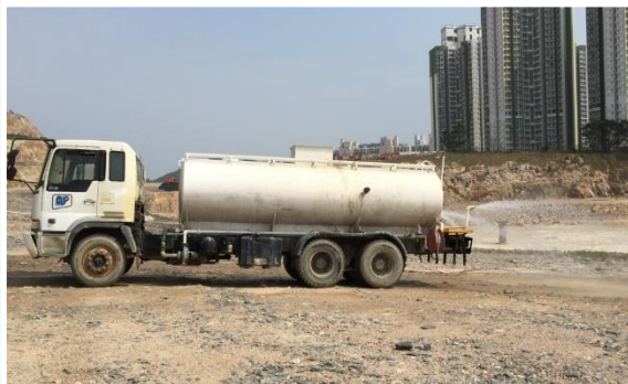
安排水車定時於工地灑水，減少產生塵埃
