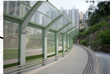
連德道與秀茂坪道路口 道路改善工程
