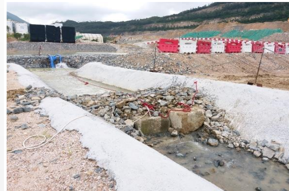
工地雨水經過過濾設施後，才排放到公共雨水渠，避免造成淤塞
